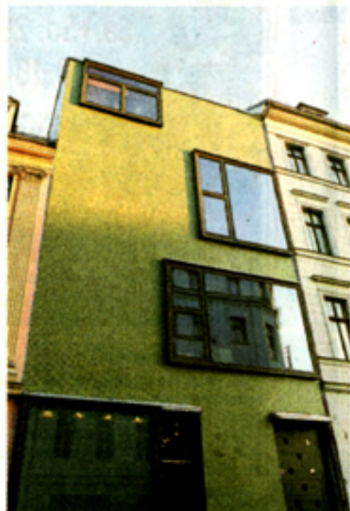
Lückenfüller. Jörg Ebers hat in der Auguststraße (Mitte) ein Kunststück vollbracht: 285 Wohn- und Nutzfläche gestapelt auf 75 Quadratmeter Grundfläche. Foto: Lintner
