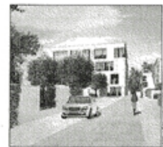
Sieht aus wie eine Vorstadt: das Bauprojekt in Stuttgart-Vaihingen
