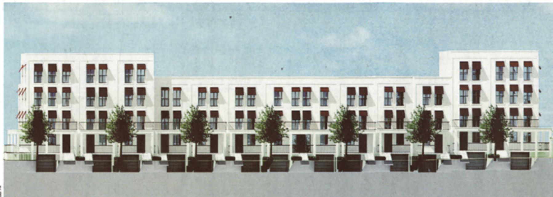
Im Bötzowviertel, einem Teil des Berliner Bezirks Prenzlauer Berg, entstehen 60 Stadthäuser und 45 Eigentumswohnungen. Mehr als die Hälfte von ihnen ist schon verkauft.
