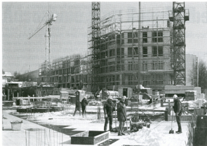
Ein Viertel des Townhouse-Quartiers »Prenzlauer Gärten« ist im Rohbau fertig.
