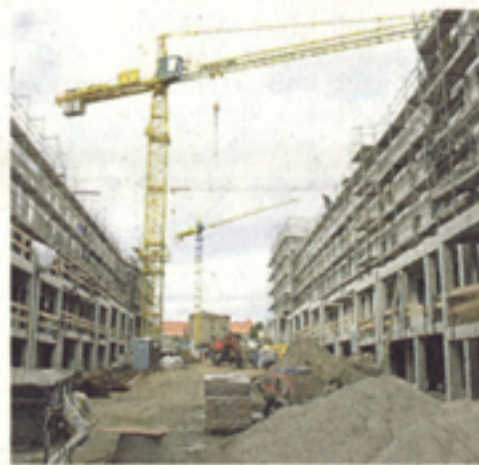
Kräne am Werk. Der gegenwärtigen Stand der Bauarbeiten. Foto: Asset-Gruppe
